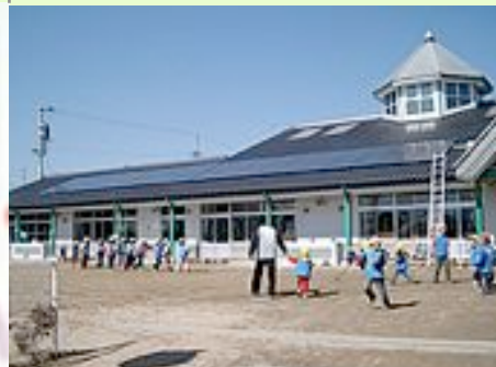
市民出資で設置された太陽光発電 (長野県飯田市)
